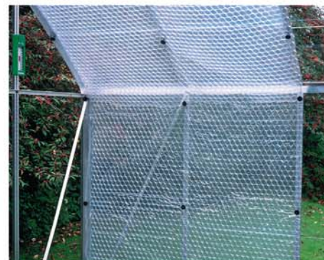
Juliana Noblefolie mindsker varmetab Juliana Noppenfolie - vermindert den Wärme- verlust Juliana Bubble wrap reduces heat loss Juliana Le film Noblefolie réduit la perte de chaleur
