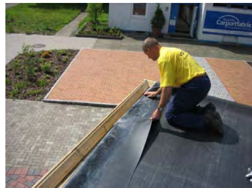
Bild 10. Plane in die Attika drücken.
