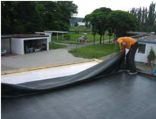
Bild 7. Plane in den Kleber schieben.
