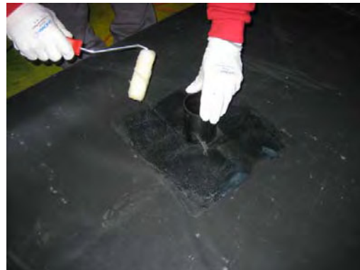
Bild 16. Verkleben des Gulliflansches.
