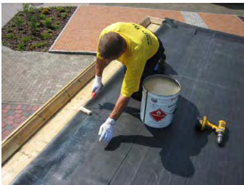
Bild 9. Einkleben der Plane.
