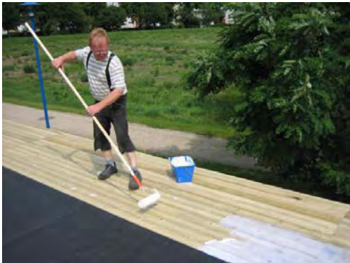
Bild 5. Klebmasse aufrollern.
