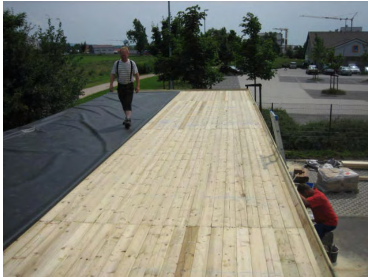
Bild 4. EPDM-Plane zur Hälfte zurückgeschlagen.
