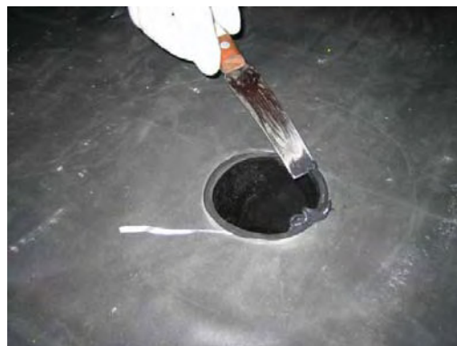
Bild 25. Ausstretende Dichtmasse entfernen.
