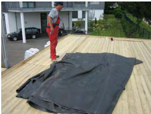
Bild 2. Ausrollen der EPDM-Plane.
