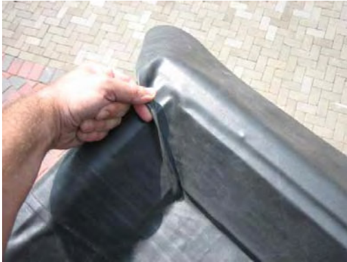
Bild 13. Einfalten der Innenecken.
