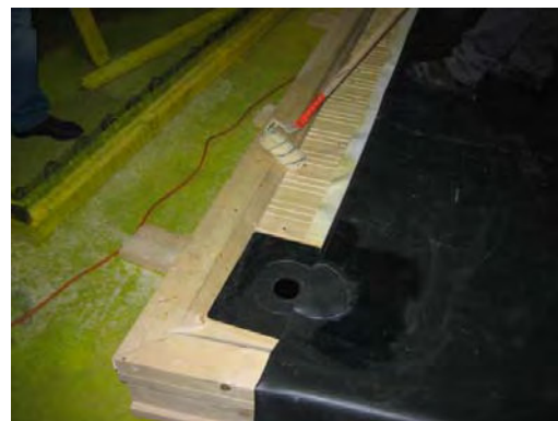
Bild 20. Flansch und Plane einkleben.
