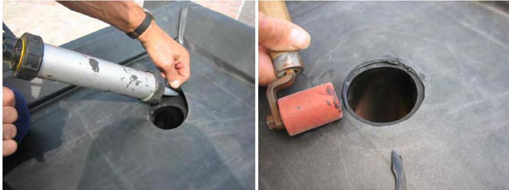
Bild 23. und 24. Abdichtung Plane – Ablaufflansch.
