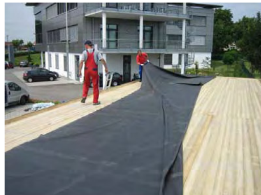
Bild 3. Plane 0,5 Stunden ruhen lassen.
