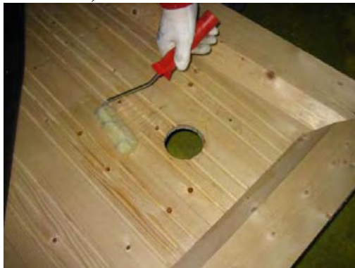
Bild 15. Verkleben des Untergrundes.
