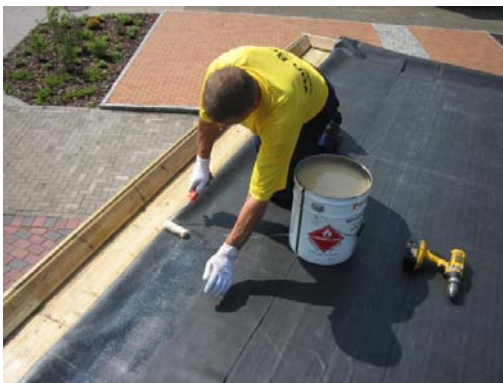
Bild 9. Einkleben der Plane.
