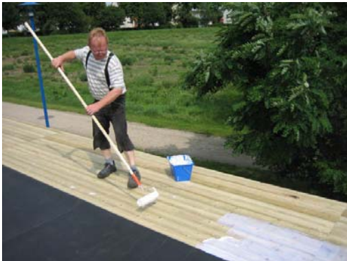
Bild 5. Klebmasse aufrollern.
