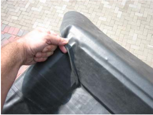
Bild 13. Einfalten der Innenecken.
