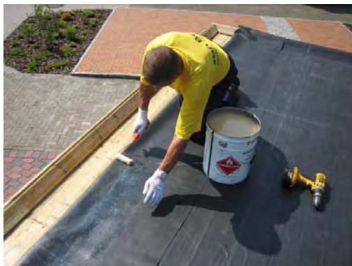
Bild 9. Einkleben der Plane.
