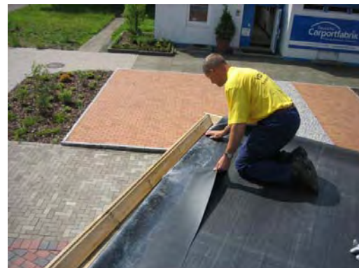
Bild 10. Plane in die Attika drücken.
