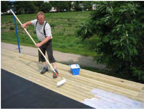
Bild 5. Klebmasse aufrollern.
