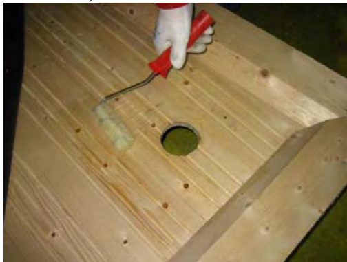
Bild 15. Verkleben des Untergrundes.
