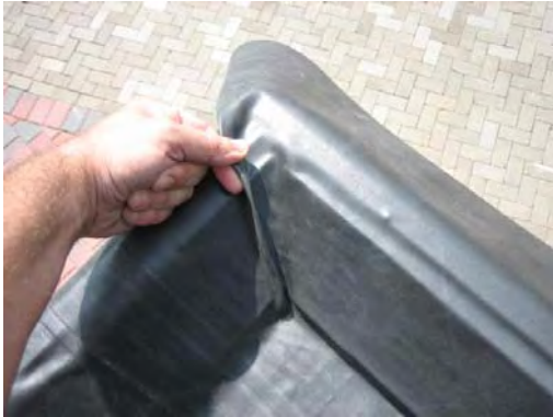
Bild 13. Einfalten der Innenecken.
