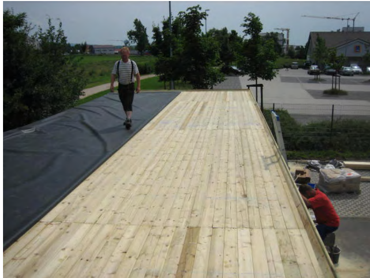
Bild 4. EPDM-Plane zur Hälfte zurückgeschlagen.
