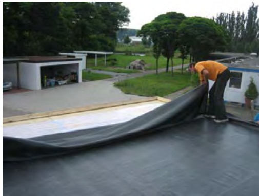
Bild 7. Plane in den Kleber schieben.
