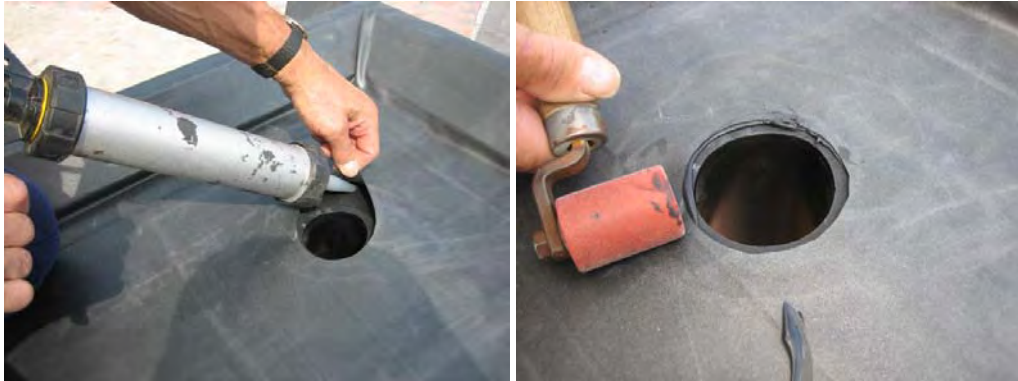
Bild 23. und 24. Abdichtung Plane – Ablaufflansch.
