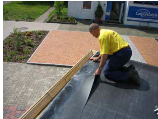
Bild 10. Plane in die Attika drücken.
