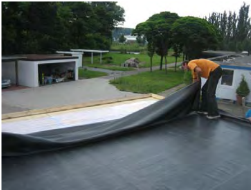
Bild 7. Plane in den Kleber schieben.
