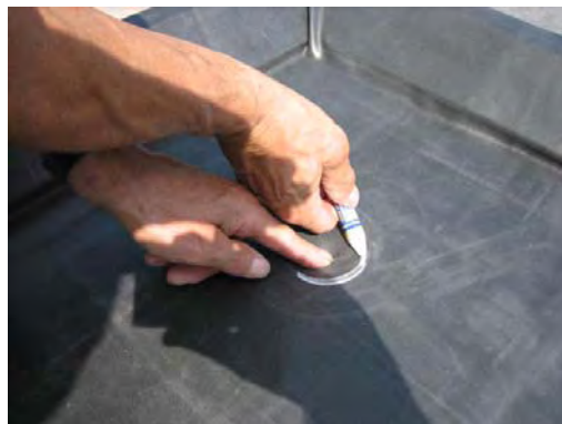
Bild 21. Kontur anzeichnen.....
