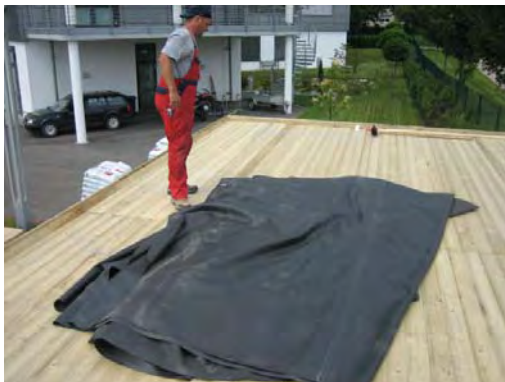
Bild 2. Ausrollen der EPDM-Plane.
