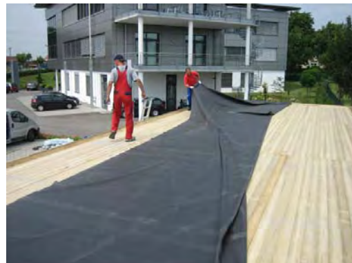
Bild 3. Plane 0,5 Stunden ruhen lassen.
