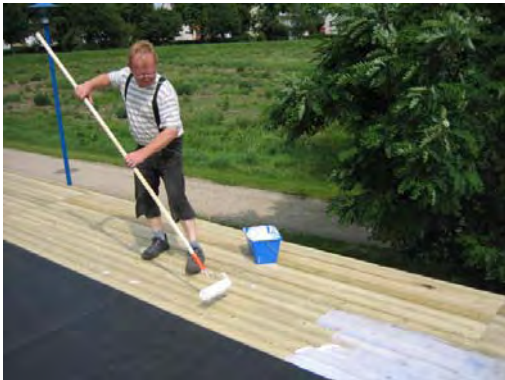
Bild 5. Klebmasse aufrollern.
