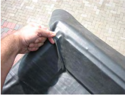
Bild 13. Einfalten der Innenecken.
