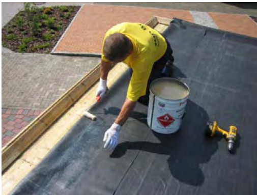
Bild 9. Einkleben der Plane.
