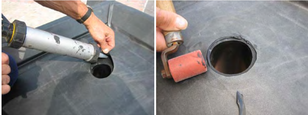
Bild 23. und 24. Abdichtung Plane – Ablaufflansch.
