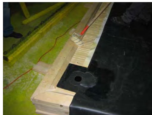
Bild 20. Flansch und Plane einkleben.
