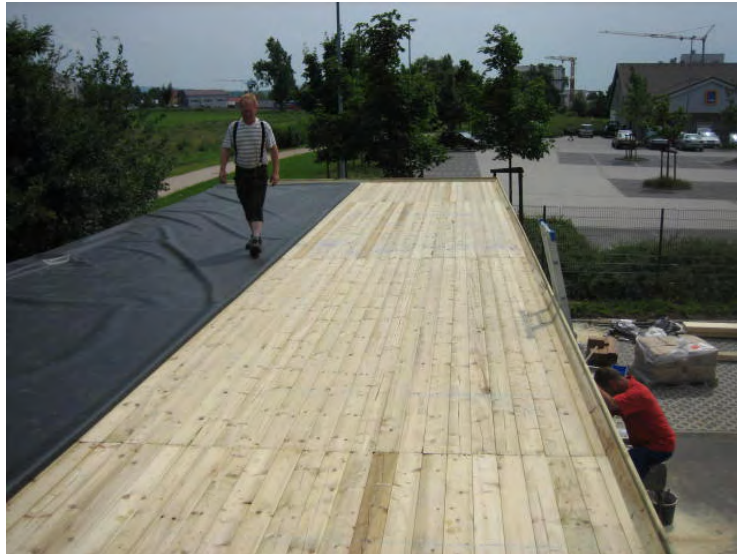
Bild 4. EPDM-Plane zur Hälfte zurückgeschlagen.
