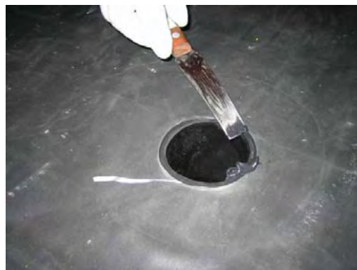
Bild 25. Austretende Dichtmasse entfernen.
