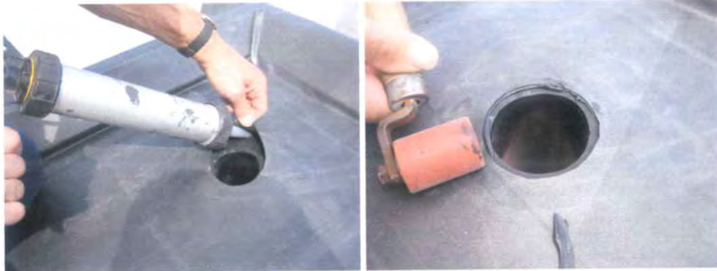
Bild 23. und 24. Abdichtung Plane – Abfuhrflansch.
