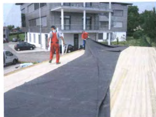
Bild 3. Plane 0,5 Stunden ruhen lassen.
