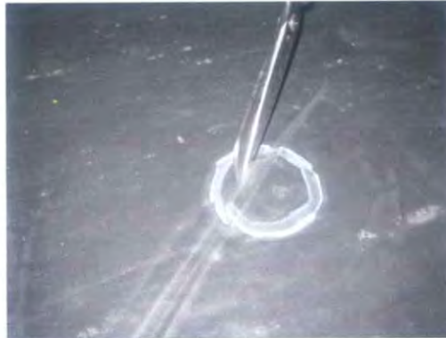
Bild 26. Ausschneiden der 2 cm kleineren Kontur.
