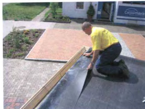
Bild 10. Plane in die Attika drücken.
