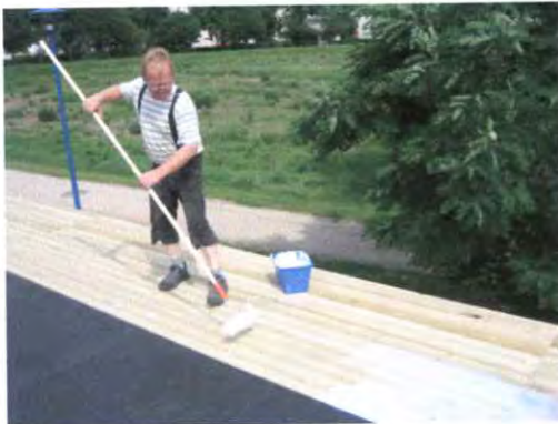
Bild 5. Klebmasse aufrollern.
