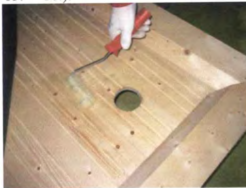
Bild 15. Verkleben des Untergrundes.
