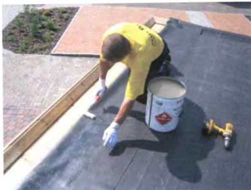
Bild 9. Einkleben der Plane.
