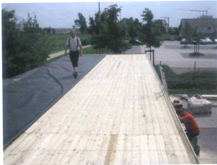
Bild 4. EPDM-Plane zur Hälfte zurückgeschlagen.
