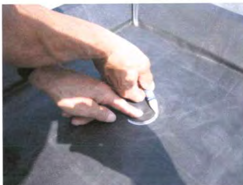
Bild 21. Kontur anzeichnen.....
