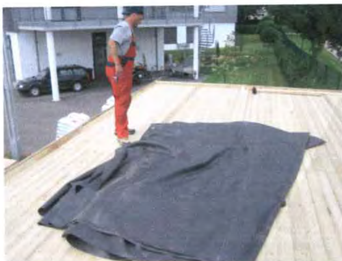
Bild 2. Ausrollen der EPDM-Plane.
