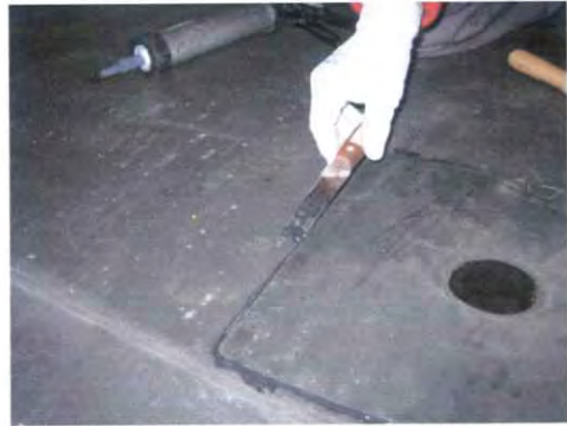
Bild 33. Wegnehmen der überflüssigen Dichtmasse.
