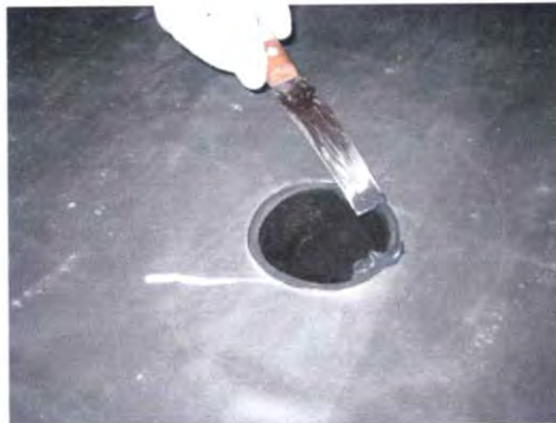
Bild 25. Ausstretende Dichtmasse entfernen.
