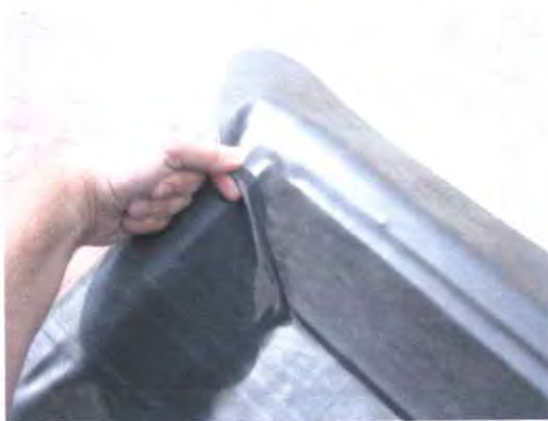
Bild 13. Einfalten der Innenecken.
