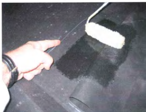
Bild 29. Klebearbeiten am Gully. 4 Cm werden freigelassen.
