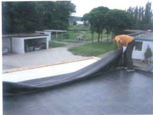
Bild 7. Plane in den Kleber schieben.
