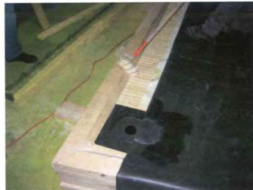
Bild 20. Flansch und Plane einkleben.
